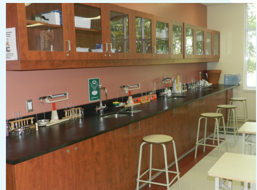
Figure 1 : L'installation d'équipements dans la classe facilite les présentations et activités de groupe. Sa localisation, adossée au laboratoire de préparation et donc à proximité de la tuyauterie, a permis de réduire les coûts de plomberie.9
